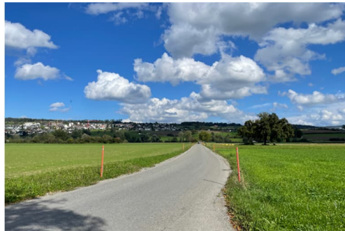
Abschnitt Reussbrücke - Oberlunkhofen
