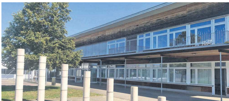
Das Schulgebäude in Islisberg ist über 20 Jahre alt. Jetzt soll die Fassade saniert werden.
