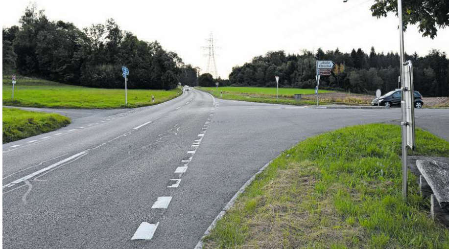
Immer wieder ein Unfallschwerpunkt: Der Abzweiger auf der Mohrentalstrasse in Richtung Rottenschwil.
