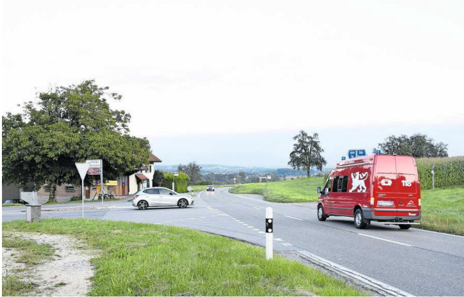
Bei der Abzweigung Mohrentalstrasse/Hauptstrasse in Rottenschwil soll ein Kreisel entstehen.
