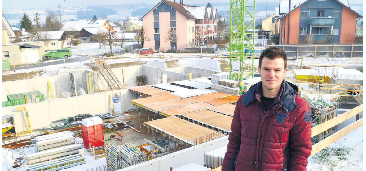
«Alles auf Kurs», sagt Nicola Küng über die Baustelle an der Käsestrasse in Rottenschwil. In rund zwei Monaten soll der Bau in die Höhe gehen.
