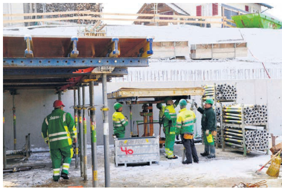
Die Schalungsarbeiten für die Decke des Kellers und der Einstellhalle laufen.
