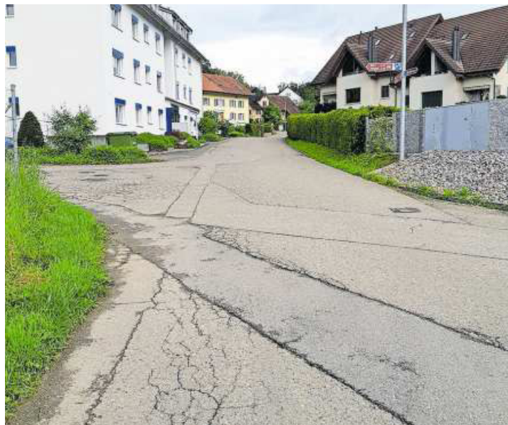
Die Werdstrasse in Rottenschwil ist schon sehr alt. Deshalb wird sie noch diesen Sommer erneuert.
