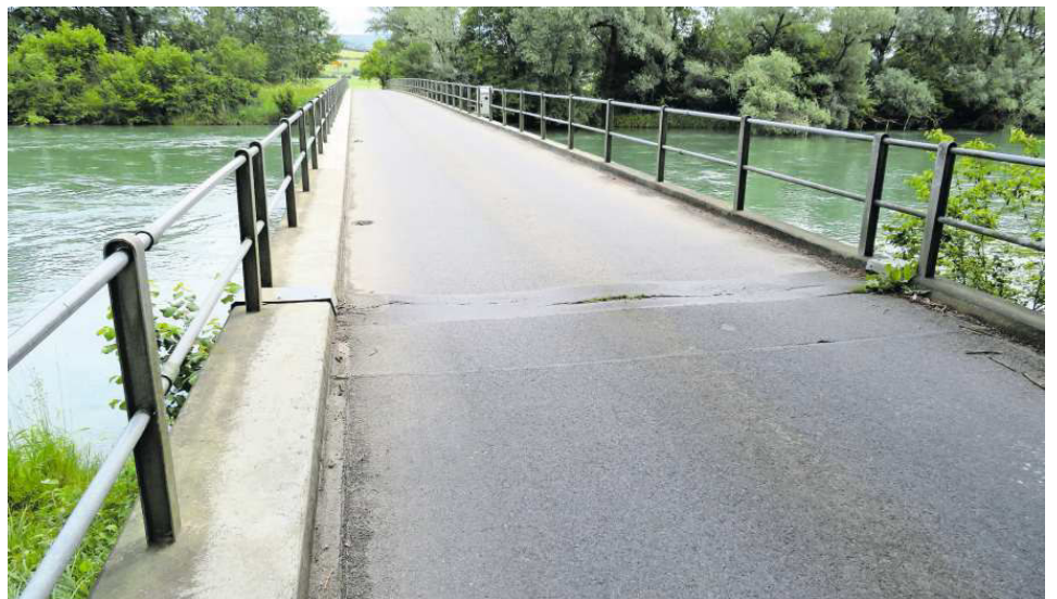
Die Werdbrücke bekommt eine Sanierung, die bis Frühling 2026 abgeschlossen sein soll.
