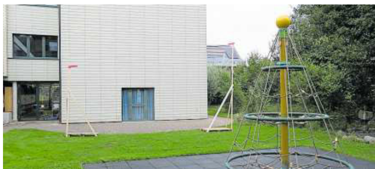
Die Bauprofile zeigen die Masse des geplanten Kindergarten-Anbaus.
