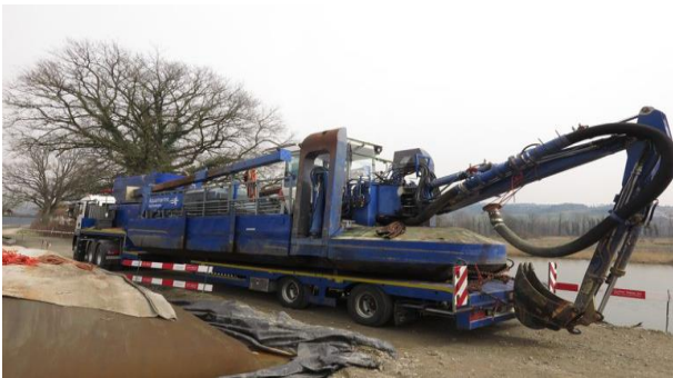
Abtransport des Saugbaggers. Der Lagerplatz mit den Geotubes verbleibt noch länger, bis das abgesaugte Material abgetrocknet und abtransportiert werden kann. (16.03.2022, Josef Fischer)
